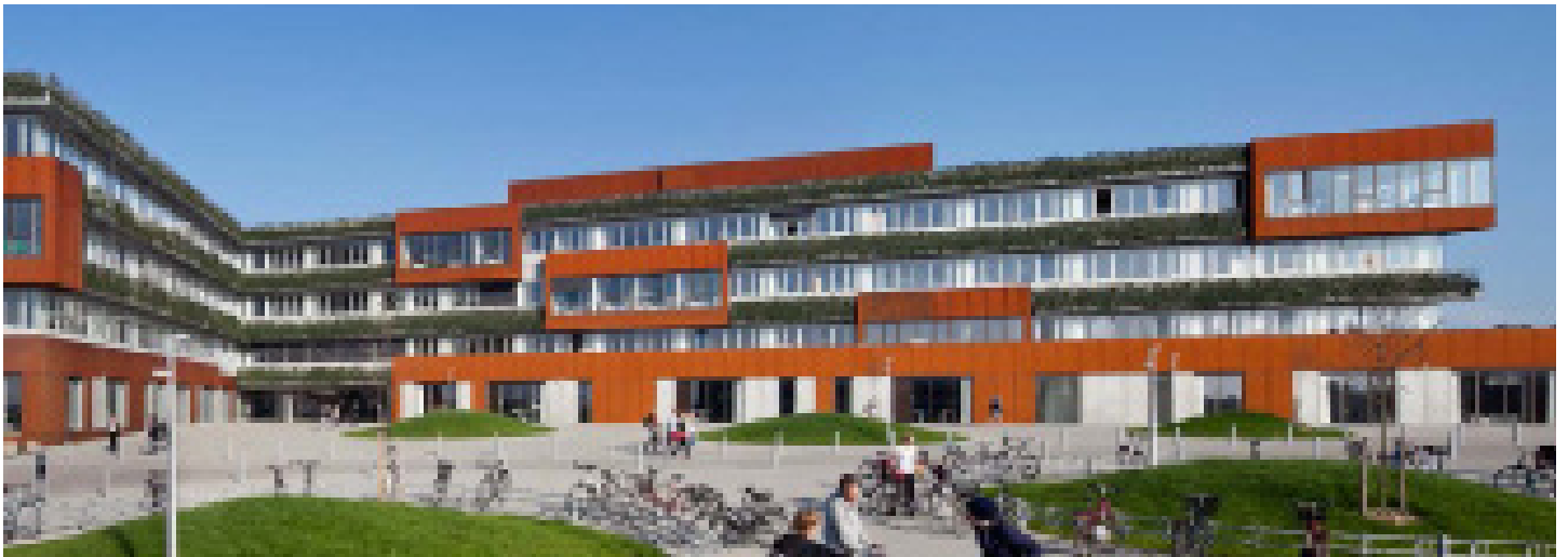
Fra udbudsmaterialet, foto af eksisterende facade.
